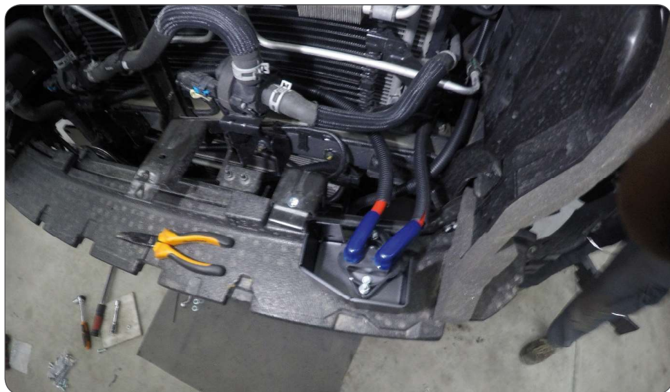
Abb. 19: Not-Aus Schalter | power switch
